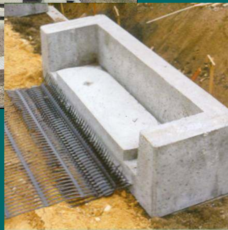
M7 autópálya Bszárszó - Ordacsehi Homlokelemes erősített talajtámfal TENSAR - GRADEX Kft.
