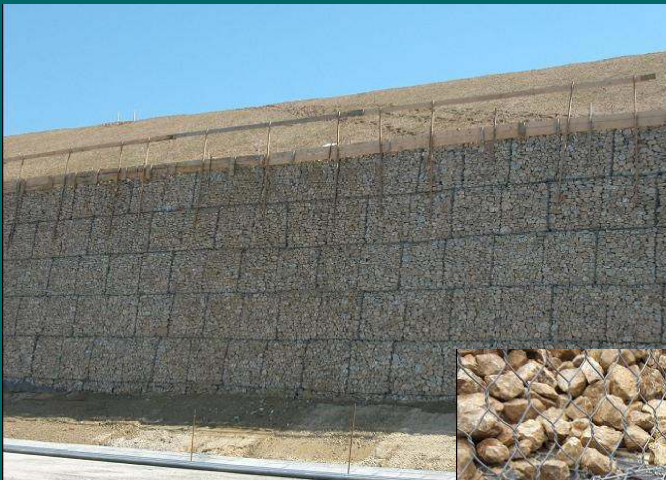
M7 autópálya Bszárszó - Ordacsehi Terra-Mesh támfal Pannon-Freyssinet
