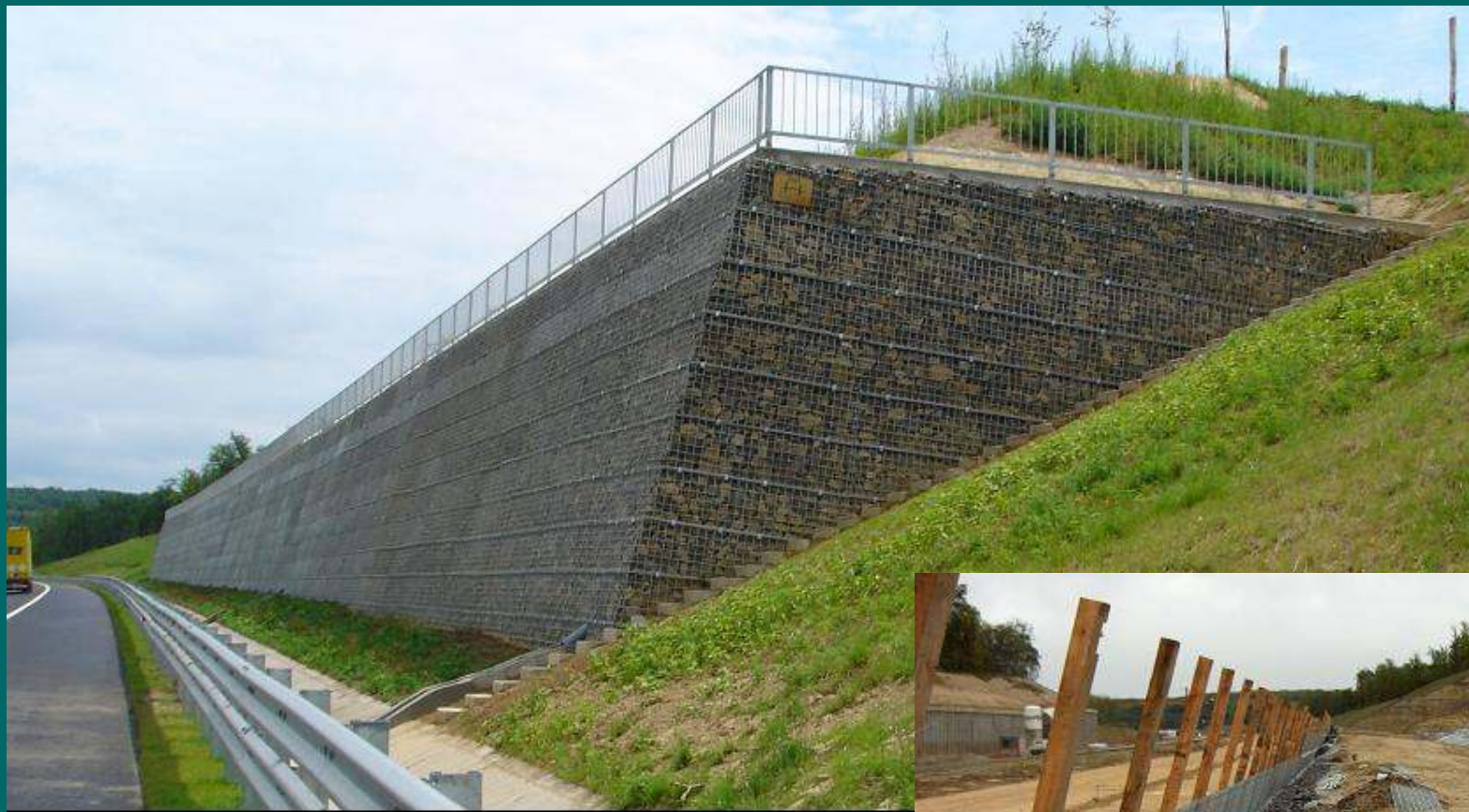
M7 autópálya Bszárszó - Ordacsehi Terra-Trel támfal Pannon-Freyssinet
